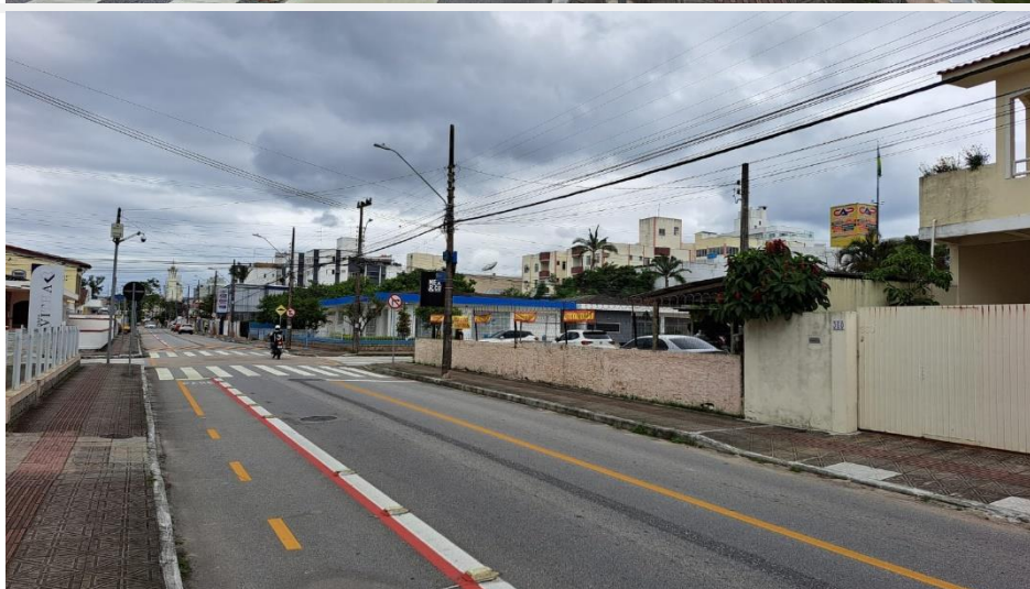
Foto 002. Vista do imóvel avaliando na Rua Sérgio Gil.
