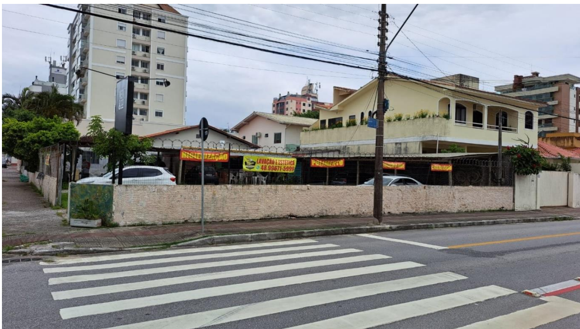
Imagem 001. Visto geral do terreno avaliando
