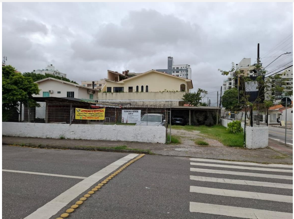
Foto 004. Vista da entrada do imóvel na Rua Vereador Batista Pereira.
